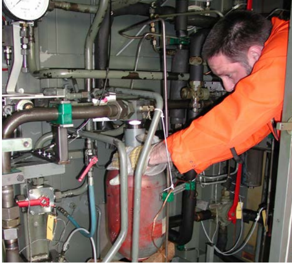
Abb. 1 Instandhalter bei Wartungsarbeiten
