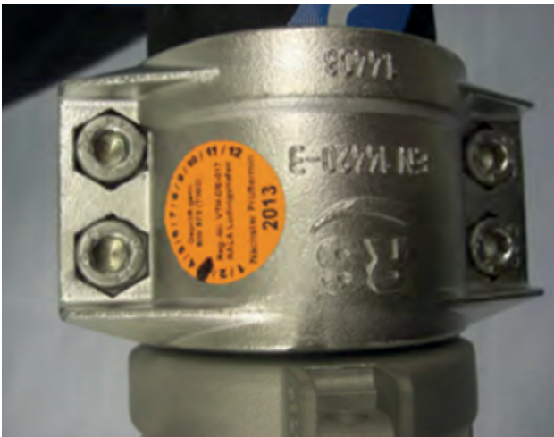
Abbildung 20: Beispiel einer farbigen Plakette zur leichteren Erkennbarkeit des nächsten Prüftermins
