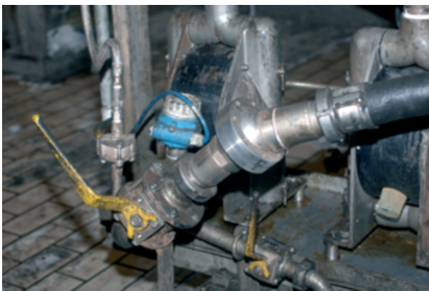
Abbildung 16b: Verlegen von Schlauchleitungen – Kugeldrehgelenk
